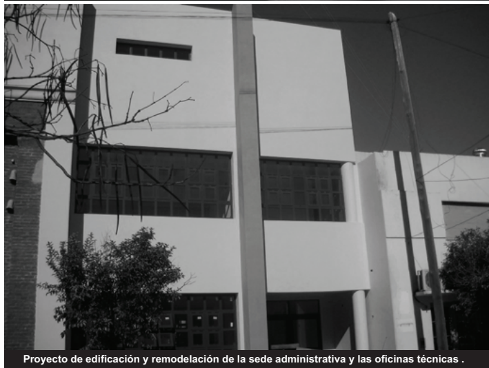
Proyecto de edificación y remodelación de la sede administrativa y las oficinas técnicas.
