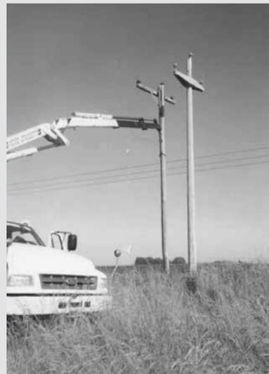
Se sigue trabajando en el mantenimiento de las redes eléctricas rurales con cambio de postación y se están realizando nuevas extensiones de líneas preensambladas de Baja Tensión en distintos barrios cumpliendo con el plan de obras estipulado, adaptando el sistema de distribución a las demandas actuales.
